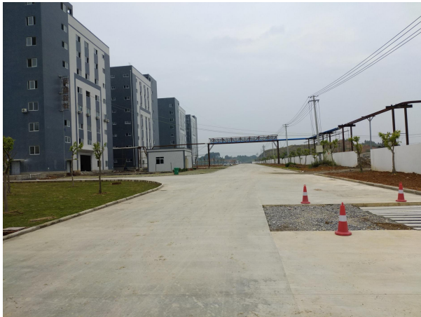
项目租赁厂房东面园区道路
