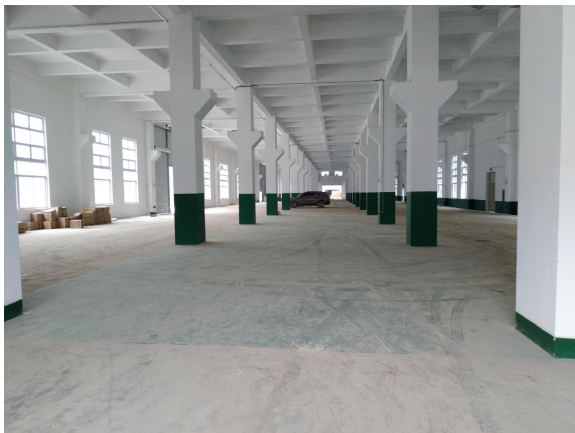
项目租赁厂房内部现状
