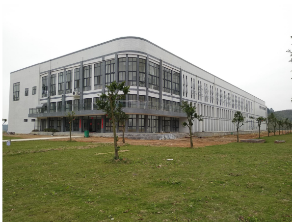
项目园区污水处理厂
