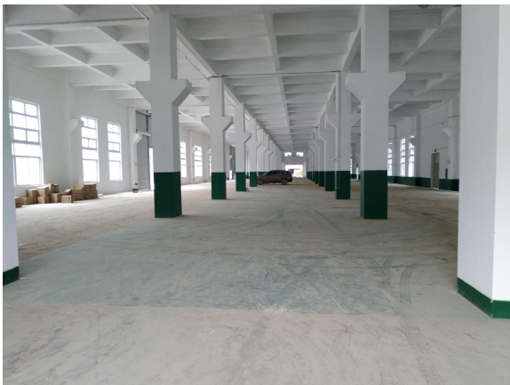
项目租赁厂房内部现状
