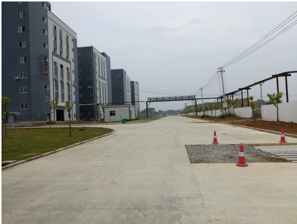
项目租赁厂房东面园区道路
