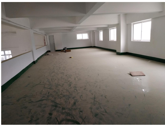
项目租赁厂房夹层现状
